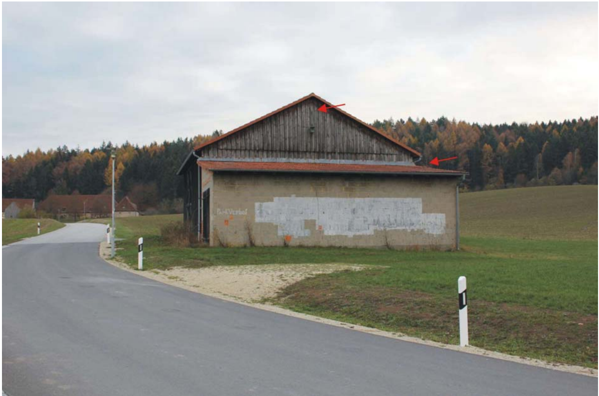
Foto: Scheune an Zufahrt, rote Pfeile zeigen Seitenwände, wo Fledermausflachkästen angebracht werden könnten
