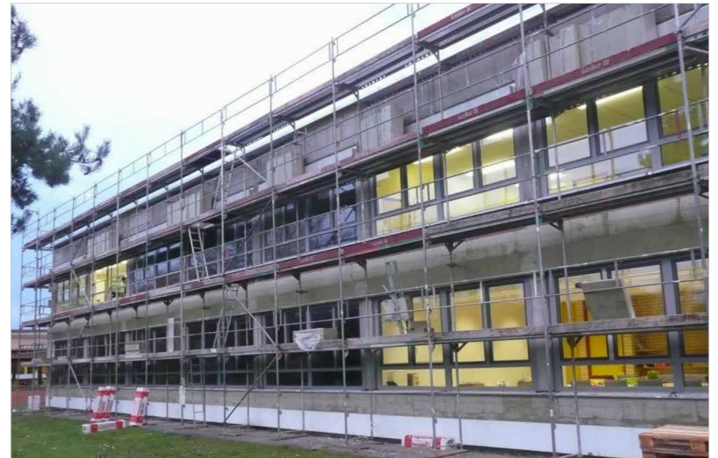
Neue Fenster, Dämmung und Außenhaut sind Teile der Vorwegmaßnahmen am Hohen Haus, die kurz vor dem Abschluss stehen.
