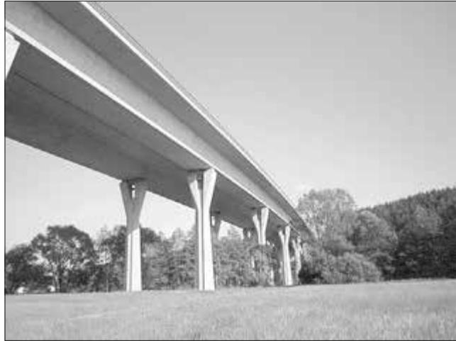
Die Spannbetonbalkenbrücke, die zwischen den Anschlussstellen Eisfeld-Nord und Eisfeld-Süd liegt, überspannt in einer Höhe von maximal 30 m das flache Tal der Werra, die Bundesstraße 89 von Eisfeld nach Themar, die parallel verlaufende Werrabahn sowie zwei Wirtschaftswege. Gebaut wurde das im Grundriss gekrümmte Bauwerk mit zwei getrennten Überbauten bei Kosten von ungefähr 19 Millionen DM zwischen den Jahren 2000 und 2002.
