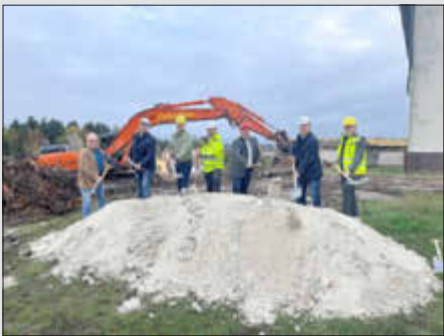
Spatenstich am Ahorner Berg.
