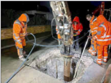
Dank der Bauhofmitarbeiter konnten Wasserrohrbrüche schnell und effektiv behoben werden.
