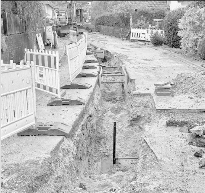
Ein Teil der Hauptwasserleitung ist bereits durch unsere Mitarbeiter verlegt und nun werden die ersten neuen Hausanschlüsse (teils offene Bauweise oder geschlossen mittels Erdrakete) durch Mitarbeiter des Bauhofes und der Gemeindewerke Ahorn hergestellt. Parallel erfolgt zudem noch die Mitverlegung einer neuen Glasfaser-Verbandleitung. Dies geschieht im Vorgriff für einen zukünftigen Ausbau, um dann ein erneutes Öffnen der neu asphaltierten Straße zu vermeiden.
